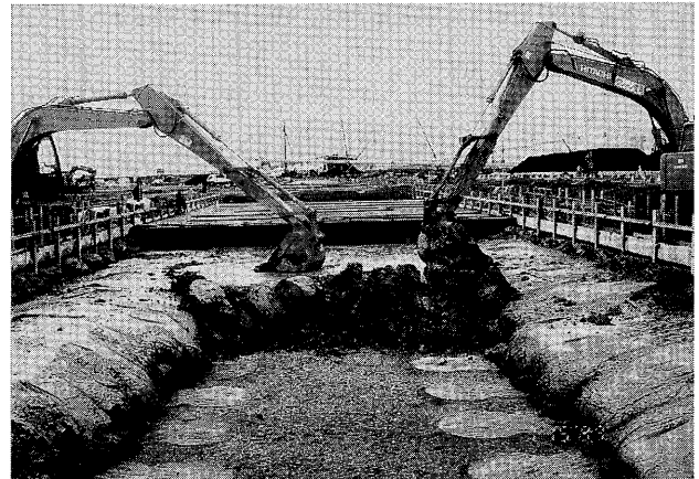
写真-1 道床基礎の施工状況
