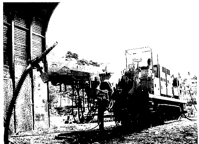
写真-1 試験に使用した吹付け機(AL-285)
