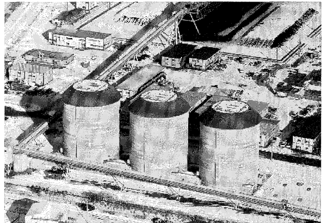
写真-1 貯炭サイロ完成状況
